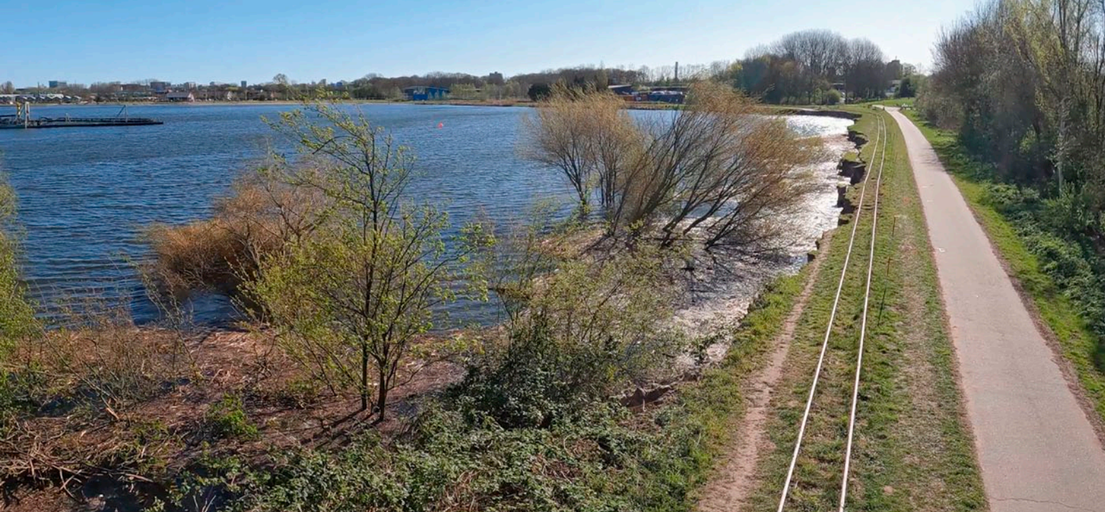
Het bedreigde gedeelte van onze spoorlijn. De bomen op de voorgrond staan rechtop in het water. Links is nog een deel van de zandzuiger te zien. Daarboven de noordoever waarop ons museum ligt. Valkenburg, 6 april 2025. Foto: George Kroon jr.
