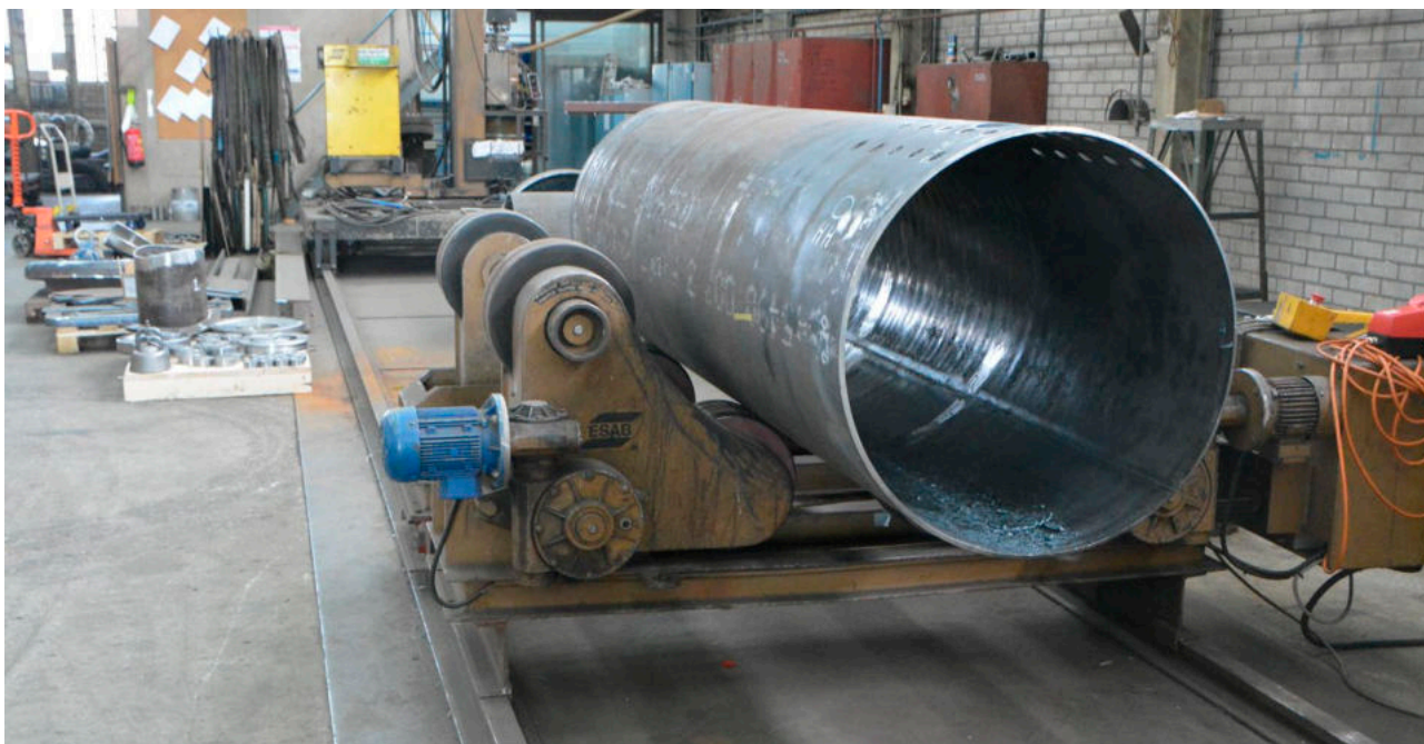
Bij Van Steen is men druk met de ketels voor twee van onze locomotieven. Hierboven de langsketel voor loc 607. Op de pallets links staan de onderdelen die in Valkenburg zijn gedraaid. Op de foto's onder de twee vuurkisten, links die voor loc 6, rechts de kist voor de 607. Foto's: Gerard de Graaf.
