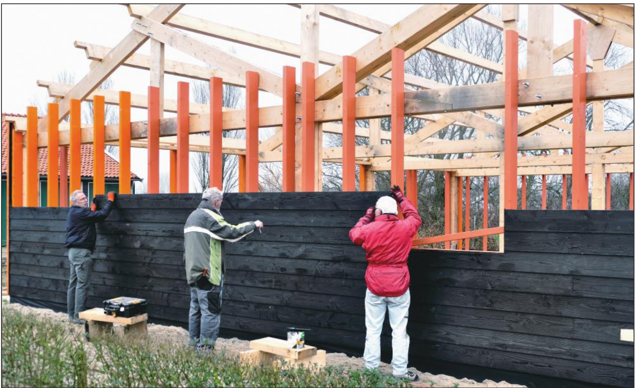
Het werk aan de Tweede Motorlocomotievenloods vordert gestaag. Foto Kees Verhoeff.
